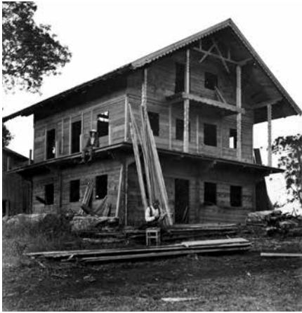
HAUSBAU IN DER NEUEN KOLONIE.
